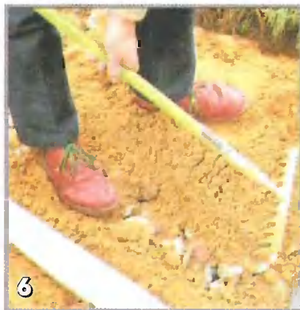
Прежде чем уплотнять песок, укладывают бордюрные камни. Если грунт в саду рыхлый, их лучше посадить на бетон
