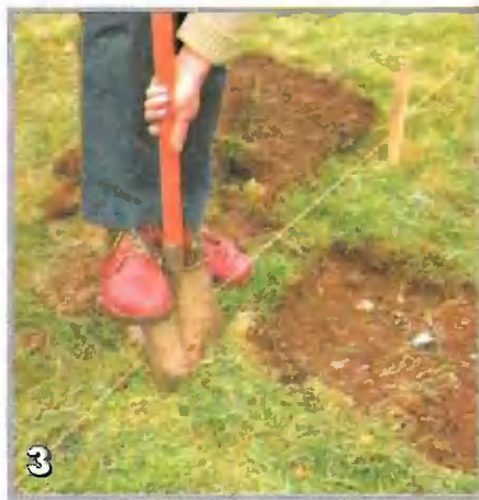
Около шнура снимают дерн, который потом будет использован при устройстве нового газона
