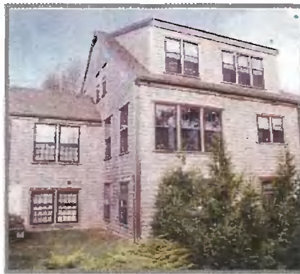
Дом с сюрпризом: обычный дом с мансардой со стороны главного фасада фактически является трехэтажным строением. Нижний этаж — отдельная квартира
