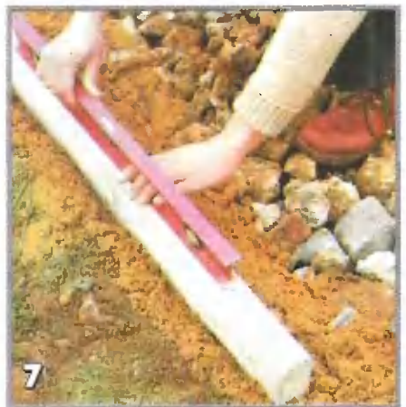
Песок тщательно разравнивают, проверяя, действительно ли под камнями ровное основание
