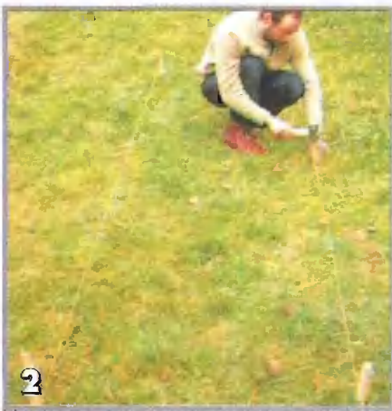
Трассу дорожки обозначают натянутыми между кольшками шнурами. На изгибах кольшки располагают плотнее друг к другу
