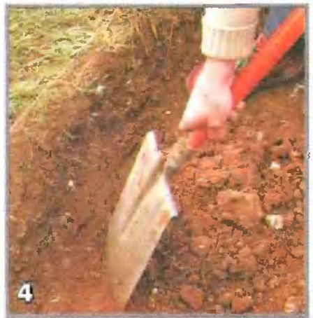
Грунт вынимают на глубину порядка 25 см. Ровно ли основание, проверяют с помощью уровня и рейки-правила
