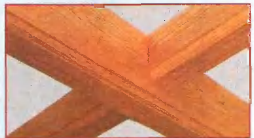
Проставки сечением 50x150 мм обшиты дубовыми планками толщиной 20 мм. Их отпиливали по длине и вставляли между основными балками
